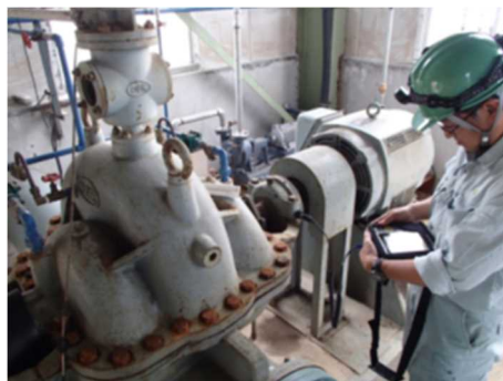
写真-1 農業用ポンプにおける振動計測状況
