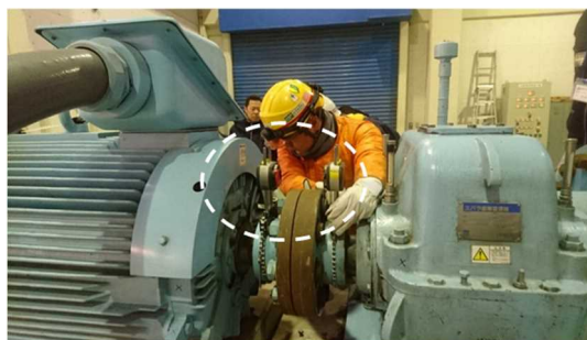
写真-2 レーザーアライメント計測状況
