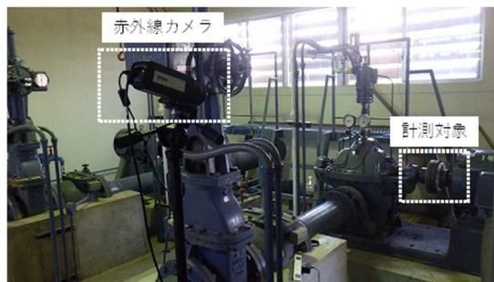
写真-3 赤外線応力計測状況
